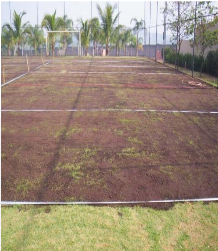
Cobertura com Forth Condicionador Gramados +Areia Média Lavada (1:1) Plantado na Base areia
